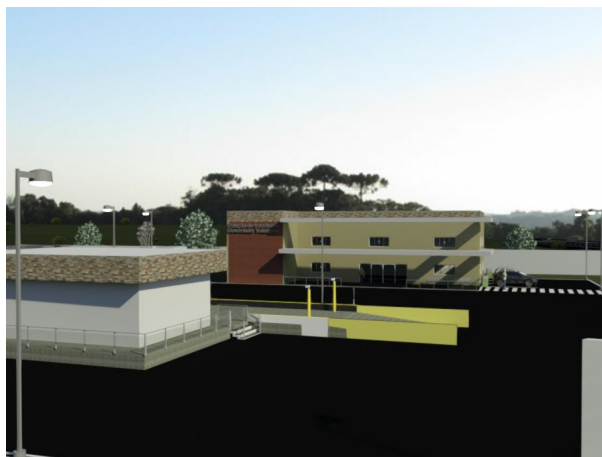
Figura 2: Pavimentação e sinalização interna. Fonte: os autores
